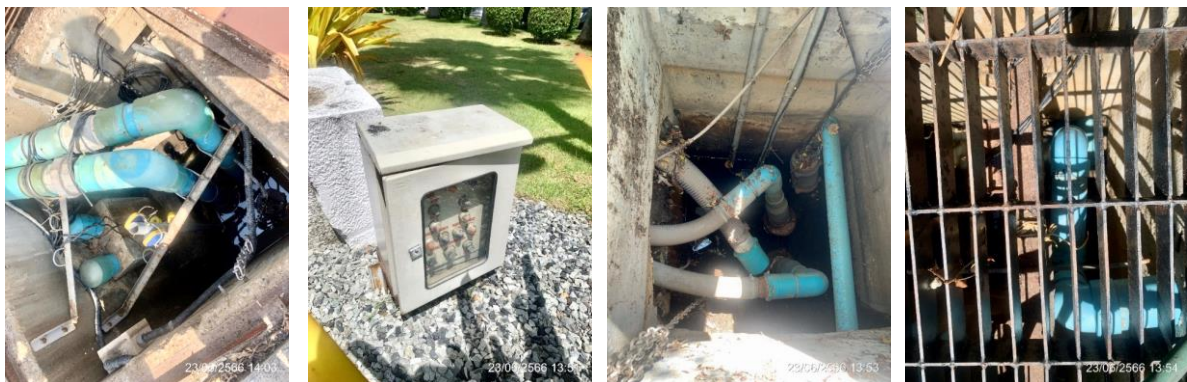
เครื่องสูบน้ำสำหรับระบายน้ำสู่ท่อระบายสาธารณะ ด้านหน้าโครงการ
