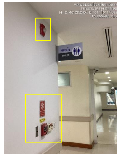
ชุดกดแจ้งเหตุแบบใช้มือถึง Manual Station และอุปกรณ์ส่งสัญญาณเสียง Strobes and Horns
