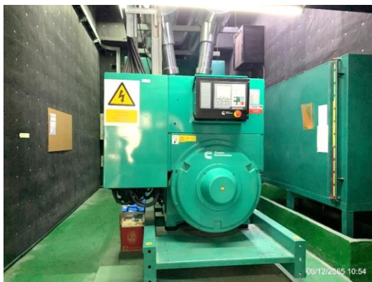
รูปที่ 2-17 เครื่องกำเนิดไฟฟ้าสำรอง
