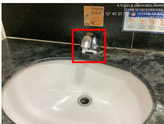
ก๊อกน้ำมีระบบเซ็นเซอร์
