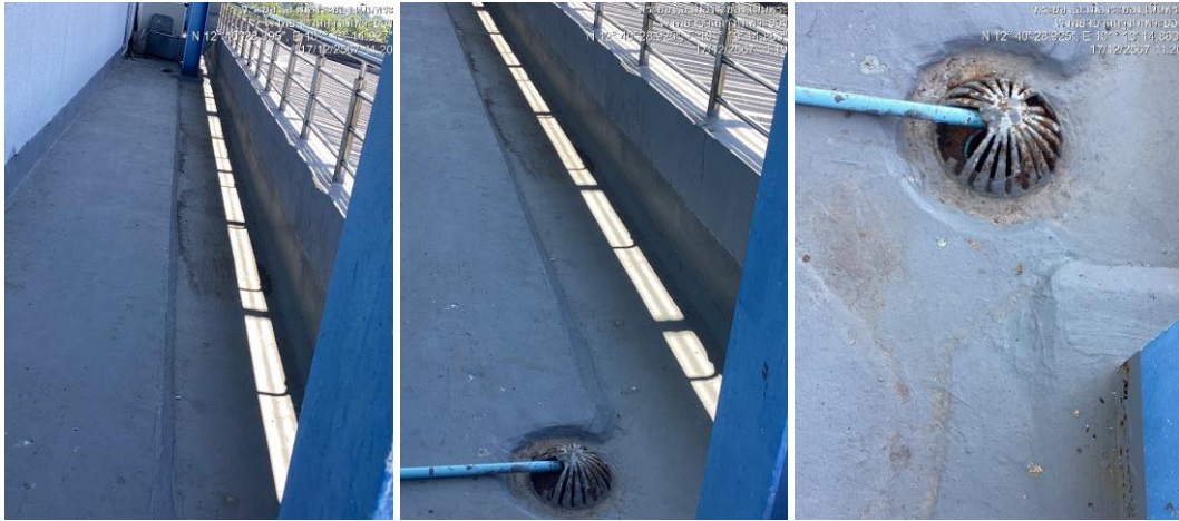
รูปที่ 2-21 เจ้าหน้าที่ตรวจสอบและทำความสะอาดรางระบายน้ำ
